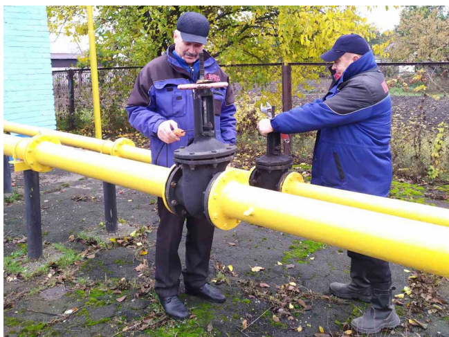
Остаточні роботи перед запуском теплопостачання
