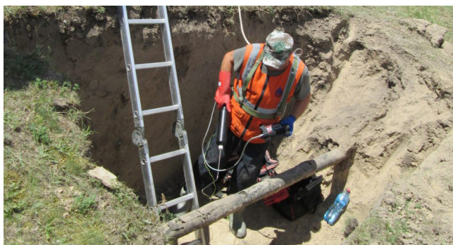
Обстеження підземної ділянки газопроводу
