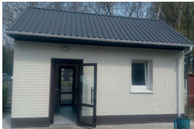
Капремонт приміщення служби охорони в Горішніх Плавнях
