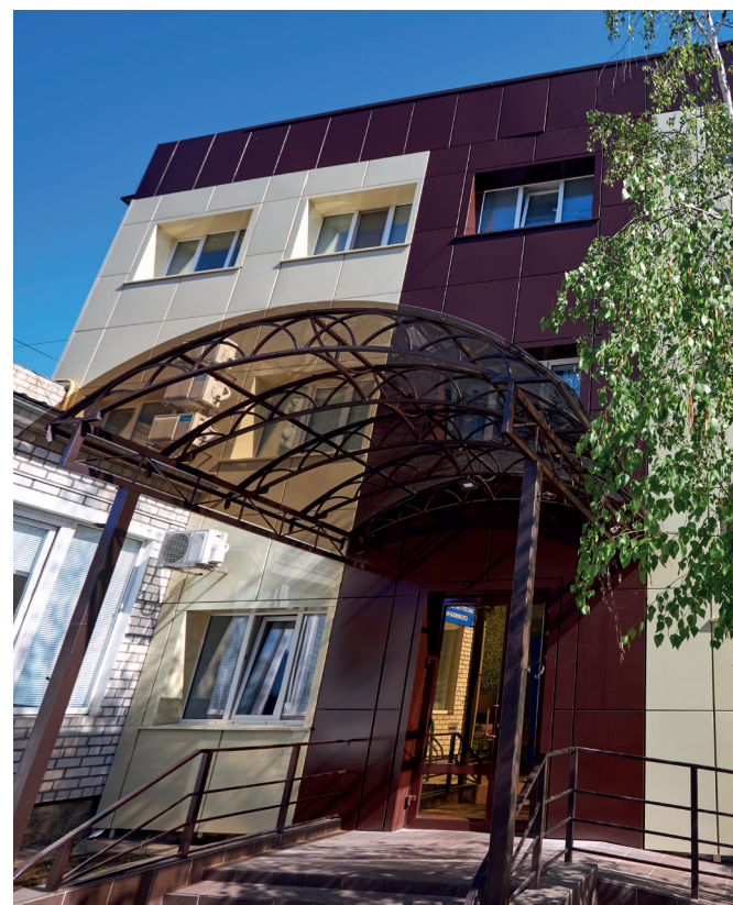
Утеплення головного фасаду будівлі ПрАТ «Кременчукгаз» – це не тільки естетична складова, а й економія теплоносія
