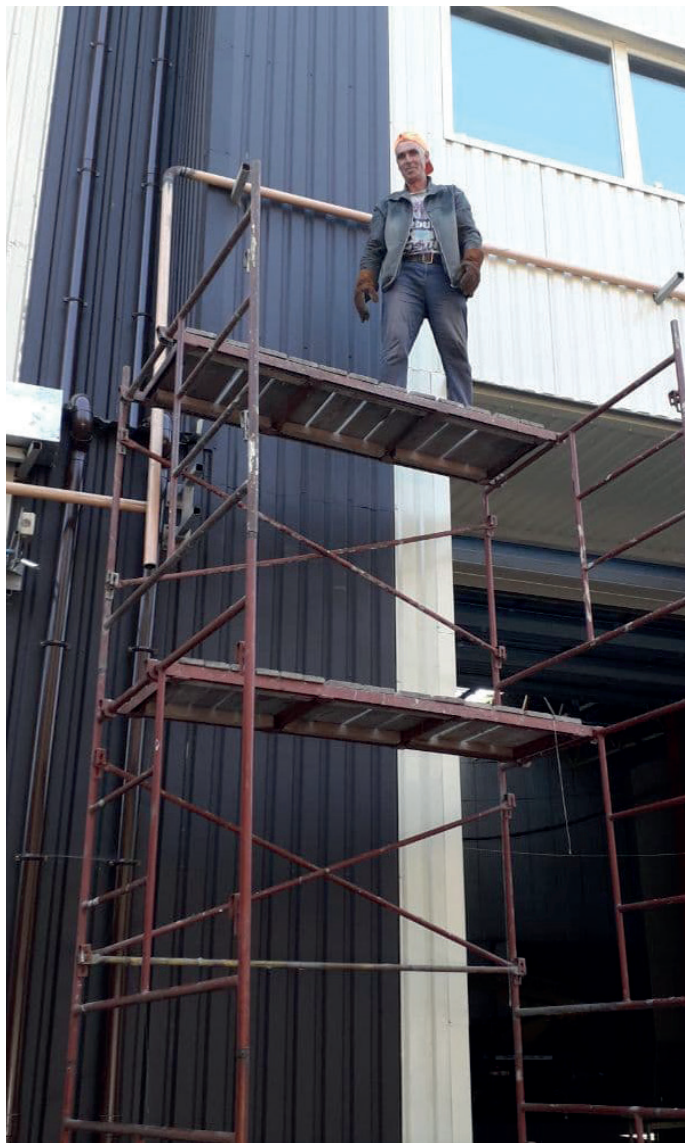
Будівництво газопроводу на підприємстві
